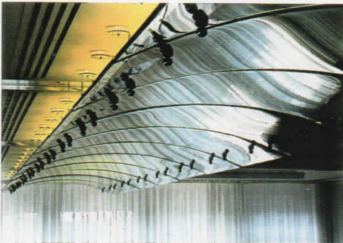
Bild 2: Landessparkasse in Oldenburg: gebogene Lichtelemente bestehend aus Gießharzverbund 2 x 6 mm Floatglas, die obere Scheibe ist teilflächenmattiert, die Gesamtstärke beträgt 14 mm
